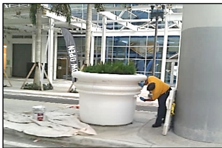
DET Planter Maintenance
